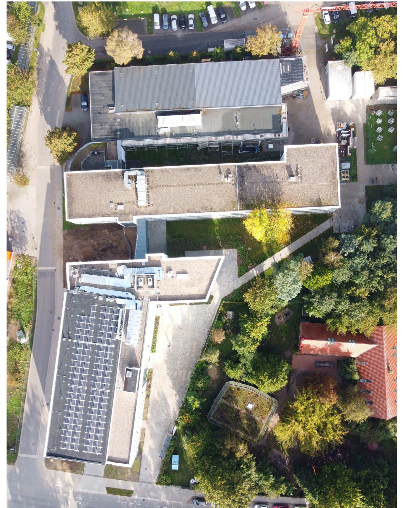
Fertig! Im August 2021 konnten die ersten Wissenschaftler:innen ins neue Gebäude einziehen – der untere Gebäudeteil mit den Photovoltaikanlagen auf dem Dach.
